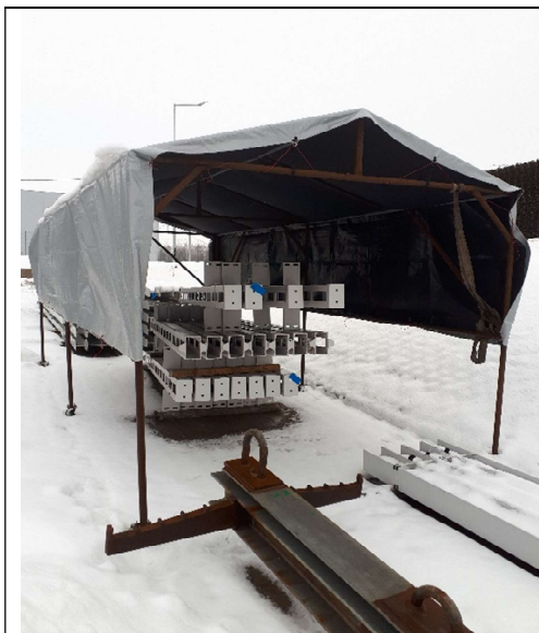
Prawidłowe przykrycie i zabezpieczenie elementów plandeką
